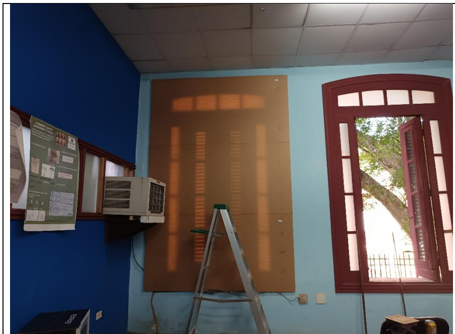
Fig1. Intentando disminuir la vulnerabilidad de los locales asociados al proyecto ARES. La foto fue tomada el día 23 de junio de 2026 después de reforzar la ventana de la izquierda, que está a punto de colapsar hacia el frente del edificio, con esfuerzos propios (Foto: E. Altshuler).
